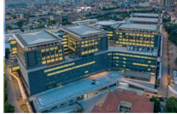
Okmeydanı / Göztepe City Hospital Istanbul / Turkey
