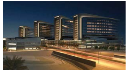
Al Mafrq Hospital Abu Dhabi / U. A. E.
