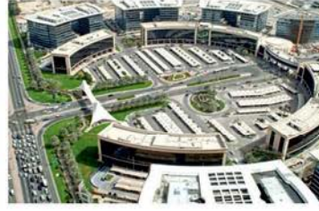
Dubai Airport Free Zone Dubai / U.A.E
